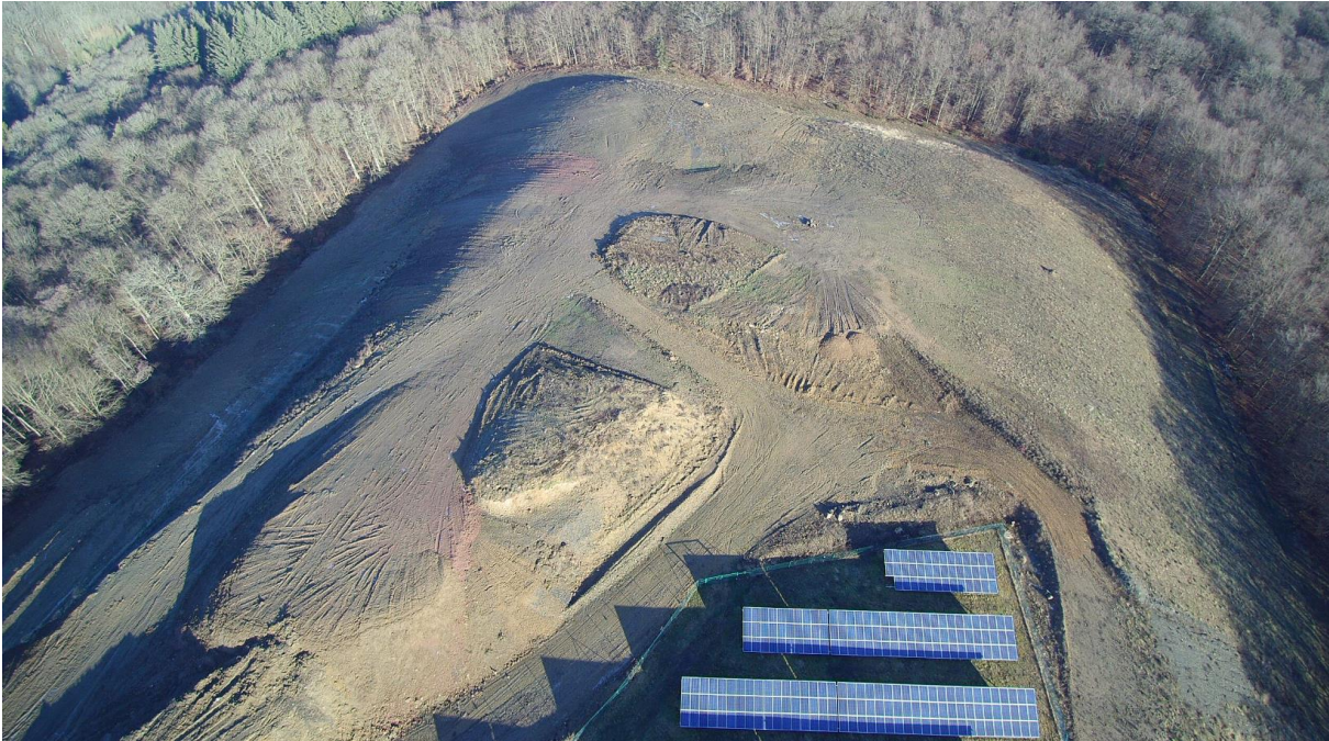
Abb. 2: Drohnenfoto der geplanten Erweiterungsfläche der Photovoltaikanlage (Drohnenfoto Herr Klein, 7x7 Energie, 2019)
