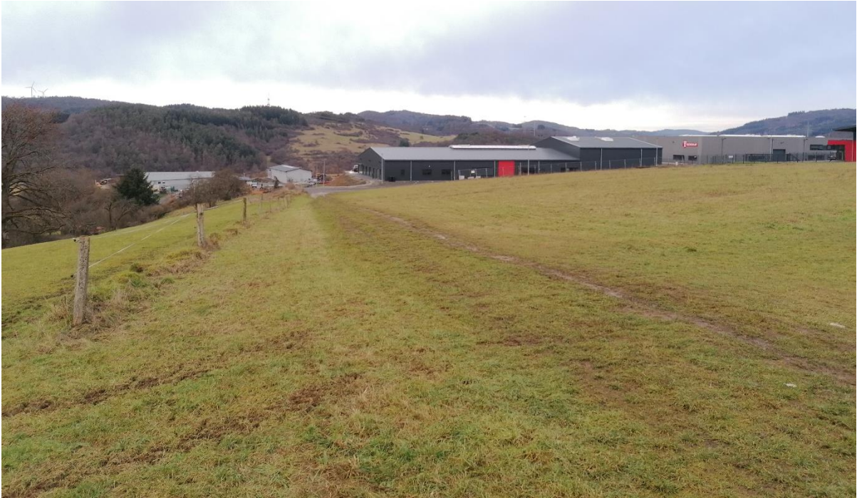
Foto 1: Blick von Südwesten nach Nordosten, Standpunkt: Südwestlicher Rand des geplanten Gewerbegebietes, Foto: Ingenieurbüro Zillinger, Januar 2021
