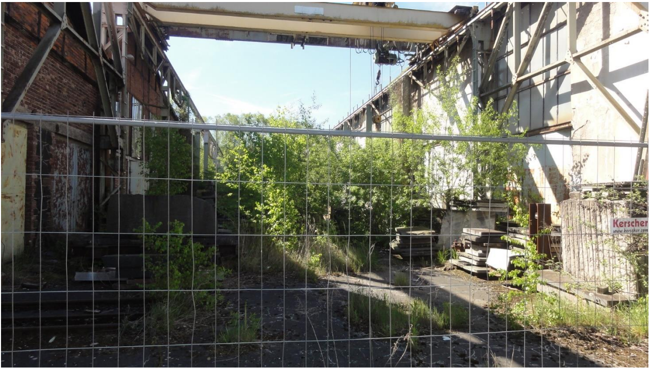
Abb. 4: Bauliche Überreste des ehemaligen Steinwerks mit fortschreitender Sukzession
